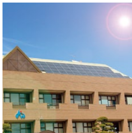
太陽光パネルを設置したことで、年間2万キロワット時の発電を行っています。
