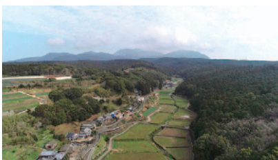
釘山地区基盤整備事業
