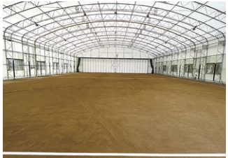
屋内交流広場(南島原市多目的運動広場)
