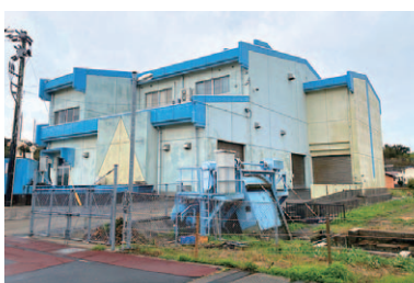
開田雨水ポンプ場
