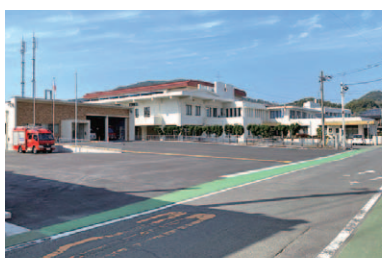
南島原消防署口之津分署
