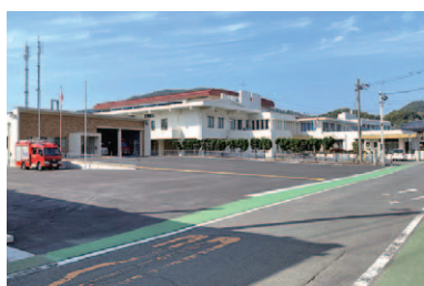
南島原消防署口之津分署
