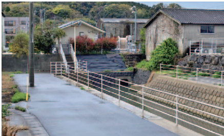
前方雨水ポンプ場
