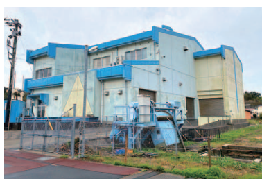
開田雨水ポンプ場
