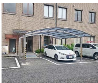
設置完了したカーポート
