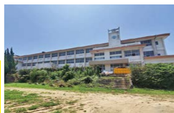
解体される旧口之津第一小学校
