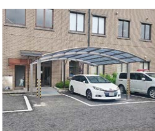
設置完了したカーポート
