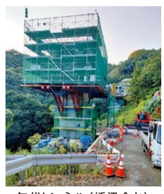
矢代トンネル(橋梁含む)
