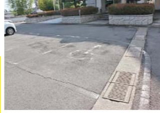
カーポートの設置・整備を
