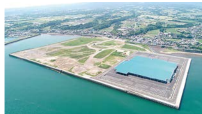
堂崎港埋立地
