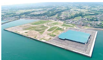
堂崎港埋立地
