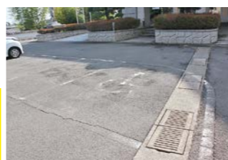
カーポートの設置・整備を
