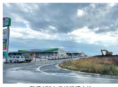
整備が進む堂崎港埋立地
