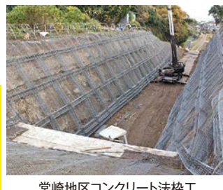
堂崎地区コンクリート法枠工
