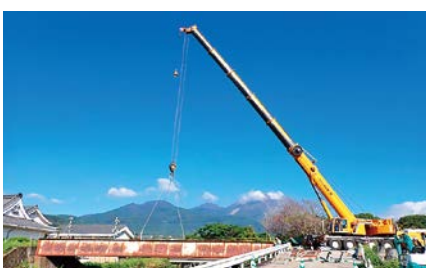
深江川の架け替え中の道路橋
