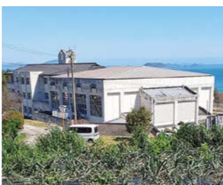
廃校に伴い社会体育施設に移した体育館
