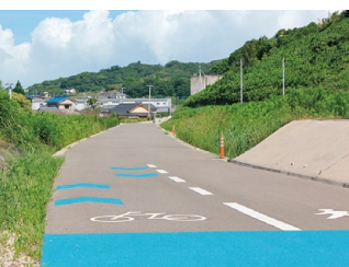
防犯灯の設置が望まれる通学路
