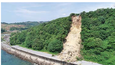
国道251号(赤間～権田間)被災状況
