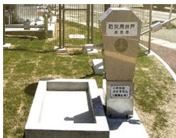
熊本県志志市防災井戸
