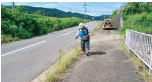
国道の除草剤散布作業状況
