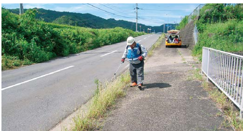
国道の除草剤散布作業状況
