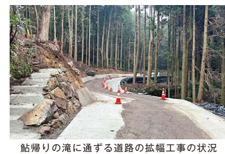
鮎帰りの滝に通ずる道路の拡幅工事の状況
