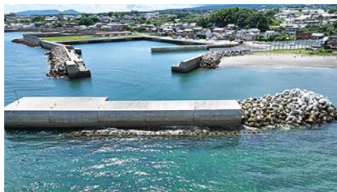
改良工事中の貝崎漁港
