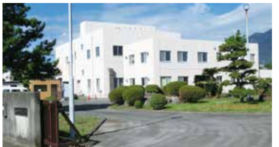
南島原市深江衛生センター
