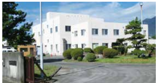
南島原市深江衛生センター
