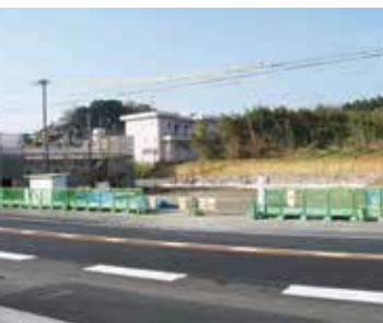
世界遺産登録に向けた駐車場工事
