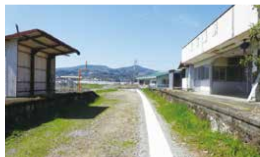
水道管布設工事(島原鉄道跡地)
