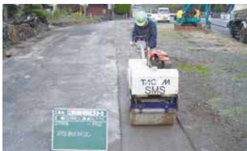
下水道工事写真
