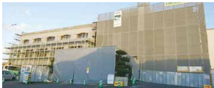
有家庁舎改修工事
