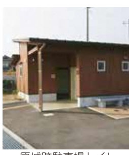
原城跡駐車場トイレ
