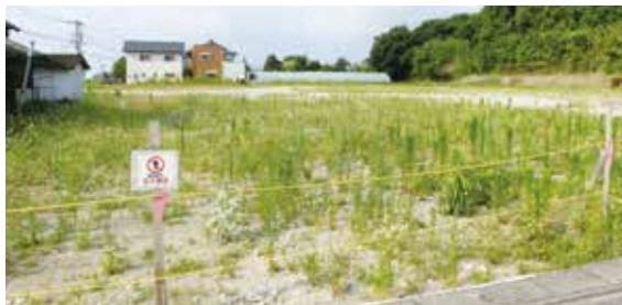
新学校給食センター建設予定地（旧龍石小学校跡地）
