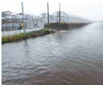
豪雨による被害
