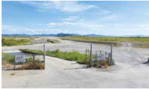
堂崎港埋立地
