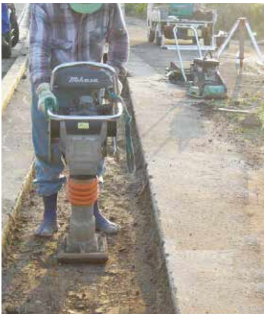
下水道工事の様子
