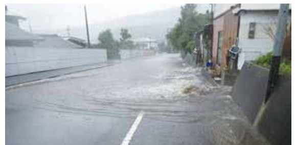
小林小学校付近道路維持補修工事予定箇所
