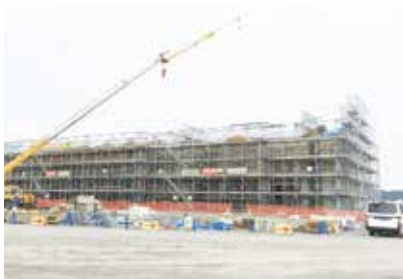
新口ノ津港ターミナル工事中(2019. 3.18)
