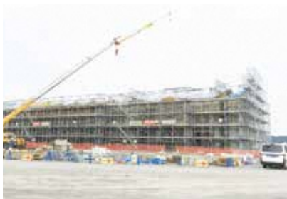
新口ノ津港ターミナル工事中(2019. 3.18)
