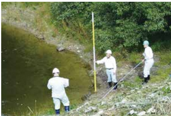
ため池の点検調査風景
