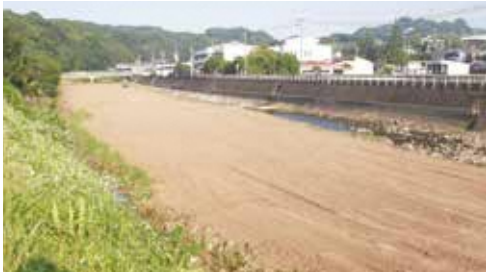
川竹が除去され整地された有馬川
