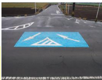
カラー舗装道路
