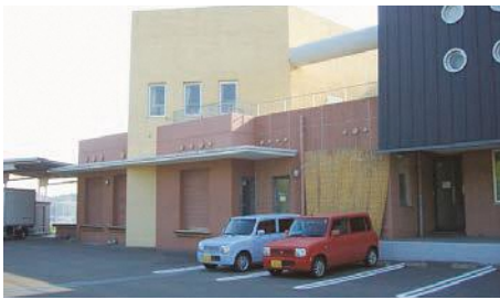
口之津学校給食センター
