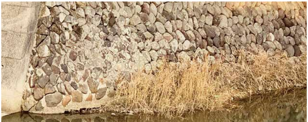
加津佐地区柳川河川維持補修工事
