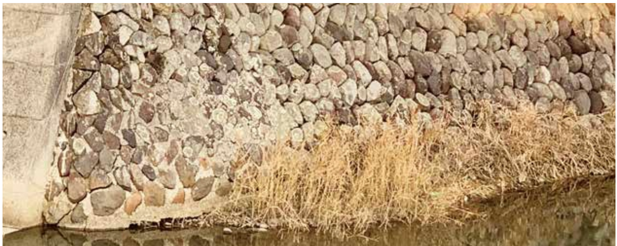
加津佐地区柳川河川維持補修工事
