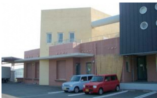
口之津学校給食センター
