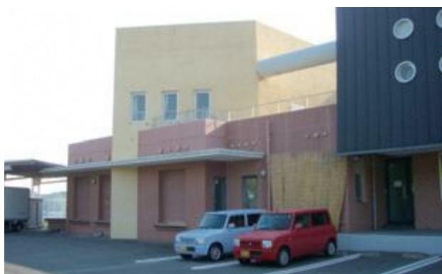
口之津学校給食センター
