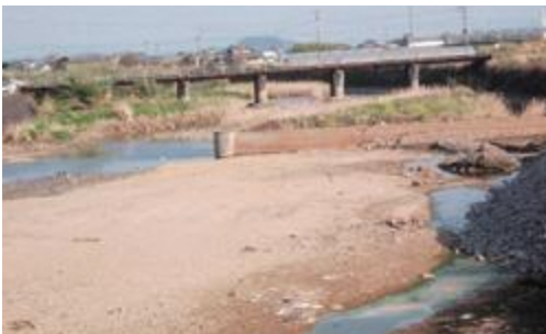
有馬川の可動堰、改修工事の様子
