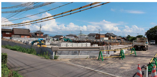
工事進行中の新学校給食センター(旧龍石小学校跡地 西有家町)
