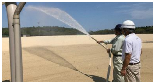
散水栓試運転の様子（布津グラウンド）
