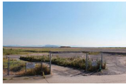
堂崎港埋立地
