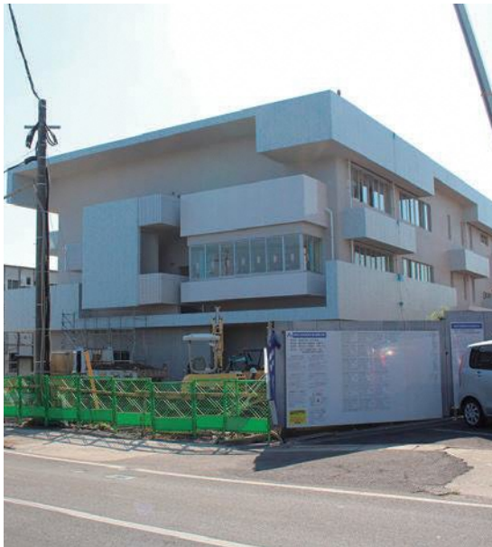
建設工事中の有幼小学校
