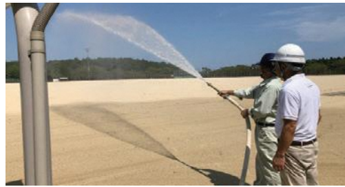
散水栓試運転の様子（布津グラウンド）
