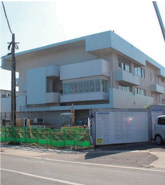
建設工事中の有幼小学校
