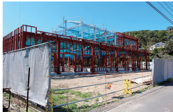
工事進行中の新学校給食センター(旧龍石小学校跡地 西有家町)
