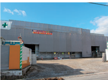
建設中の新学校給食センター（旧龍石小学校跡地 西有家町）
