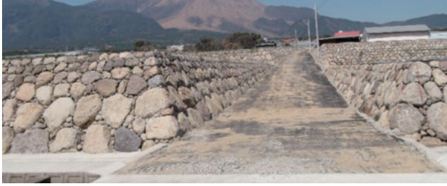
基盤整備（深江町諏訪地区）
