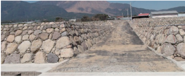
基盤整備（深江町諏訪地区）
