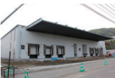
建設中の新学校給食センター (旧龍石小学校跡地 西有家町)
