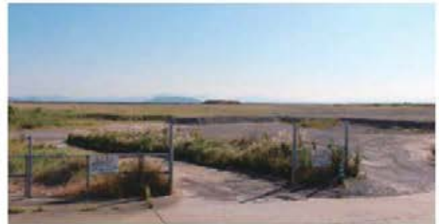
堂崎港埋立地
