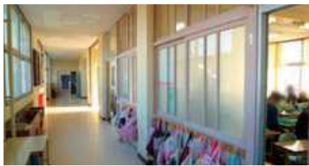
《南有馬小校舎改修工事》
